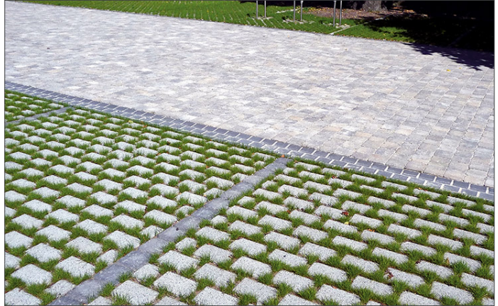
Exemple revêtement dalle parking perméable
