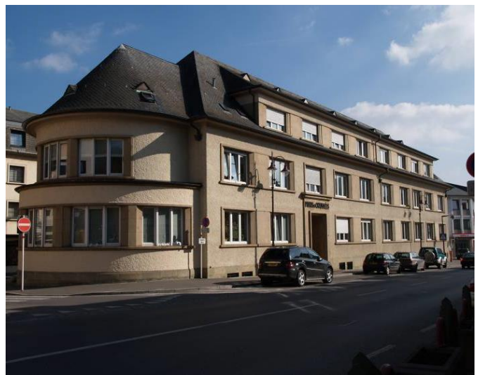
1-3, rue de Stavelot
