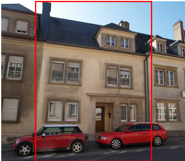
8, rue de Stavelot
