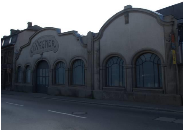
22, rue de Stavelot
