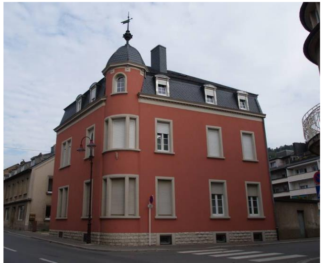
21, rue de Stavelot
