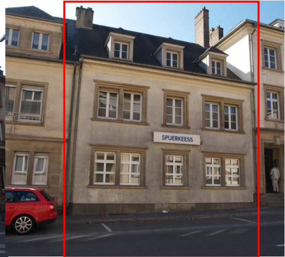
6, rue de Stavelot
