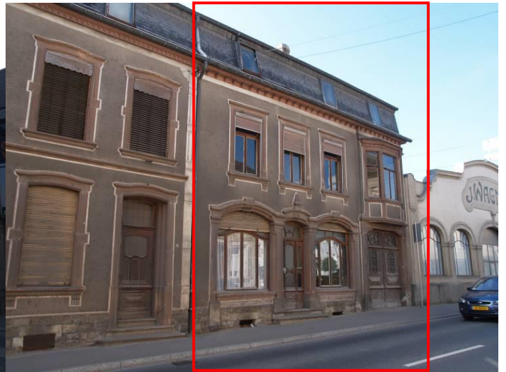
24, rue de Stavelot
