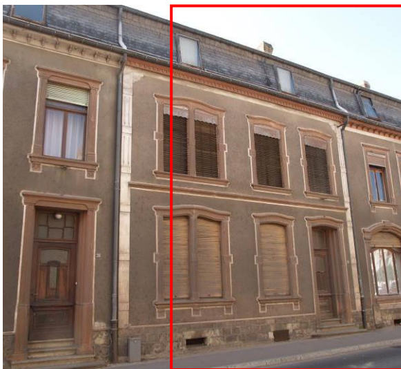
26, rue de Stavelot
