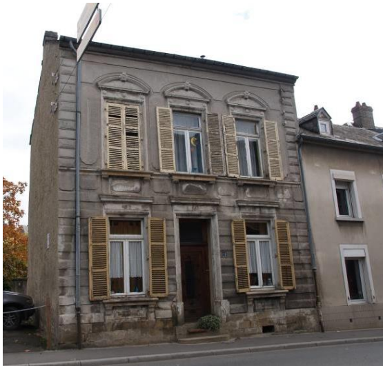
11, rue de Stavelot
