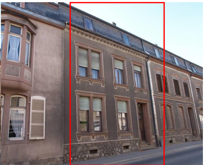
28, rue de Stavelot
