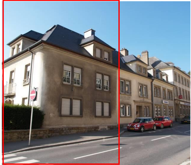
10, rue de Stavelot
