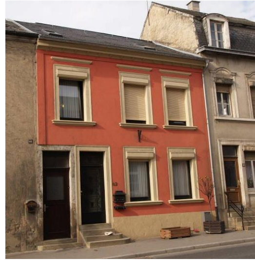
42, rue de Stavelot
