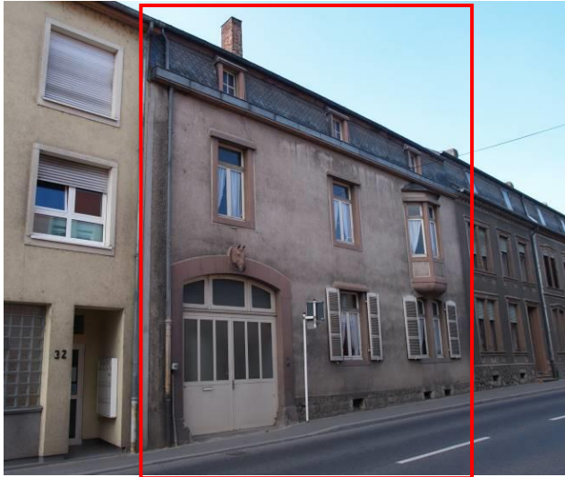
30, rue de Stavelot
