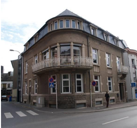
23, rue de Stavelot
