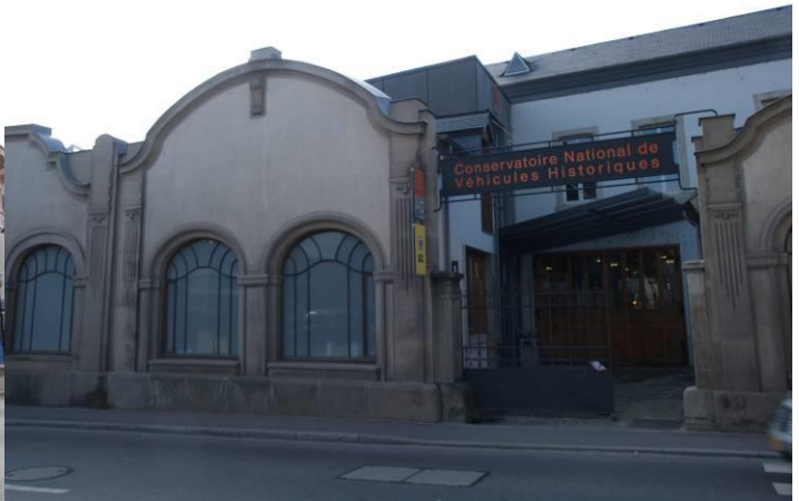
20, rue de Stavelot
