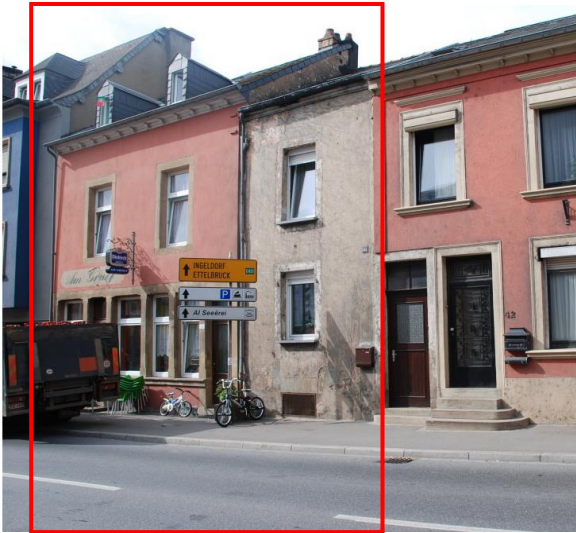
44-46, rue de Stavelot
