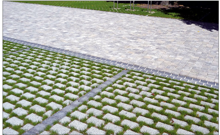
Exemple revêtement dalle parking perméable
