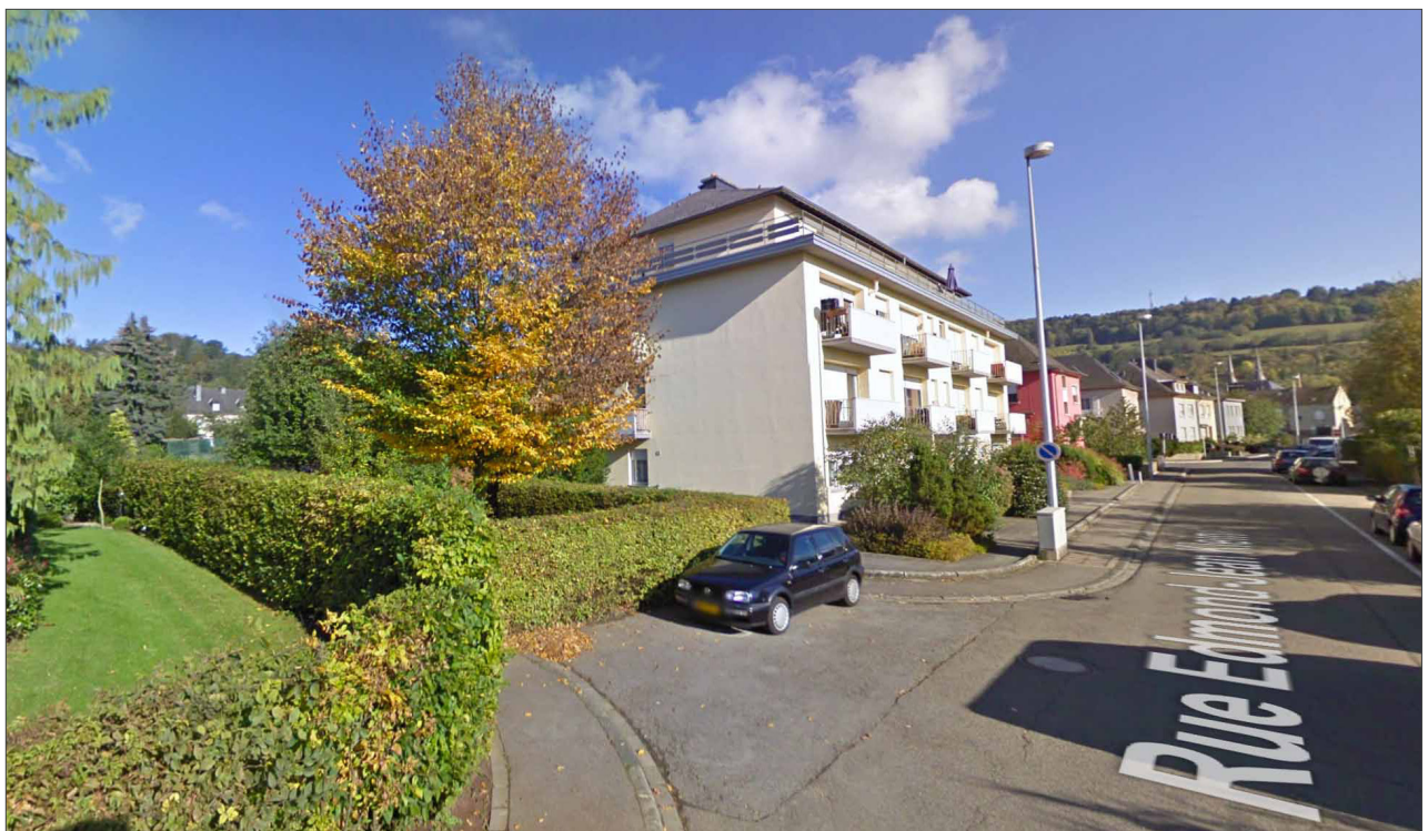
Vue de la rue Edmond-Jean-Klein en direction nord-est
